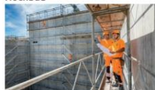
Tiefbau und Spezialtiefbau
