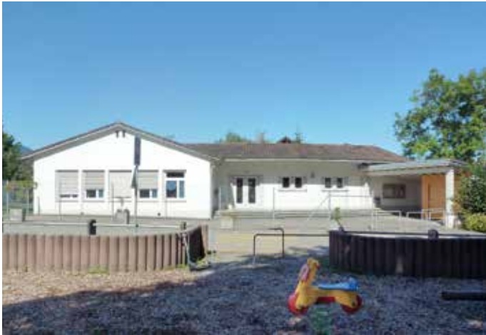
Gebäudeansicht von Osten (ab Landsgemeindeweg)
