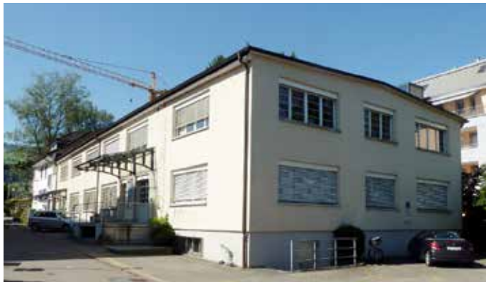
Gebäudeansicht von Nordosten (ab Gerbiweg)
