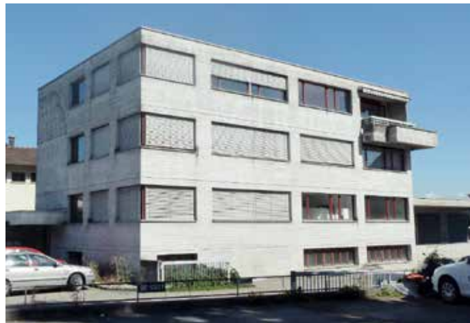
Gebäudeansicht von Südosten (ab Winkelweg)
